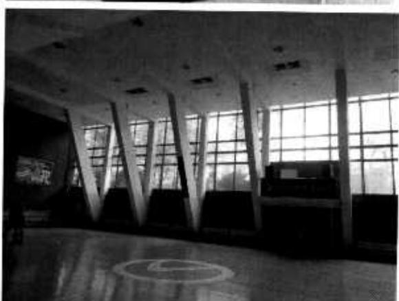
Съблекалня 1 - Тенис бункер (за обслужване на тренировъчните футболни игрища) - монолитна стоманобетонова конструкция на един етаж, 2/3 вкопана в земята.
